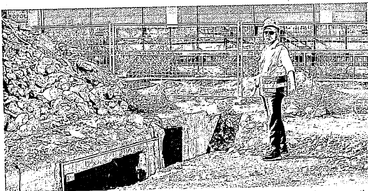
Al lavoro. Il commissario Mauro Fasano accanto a uno dei tunnel emersi durante le demolizioni e non mappati
